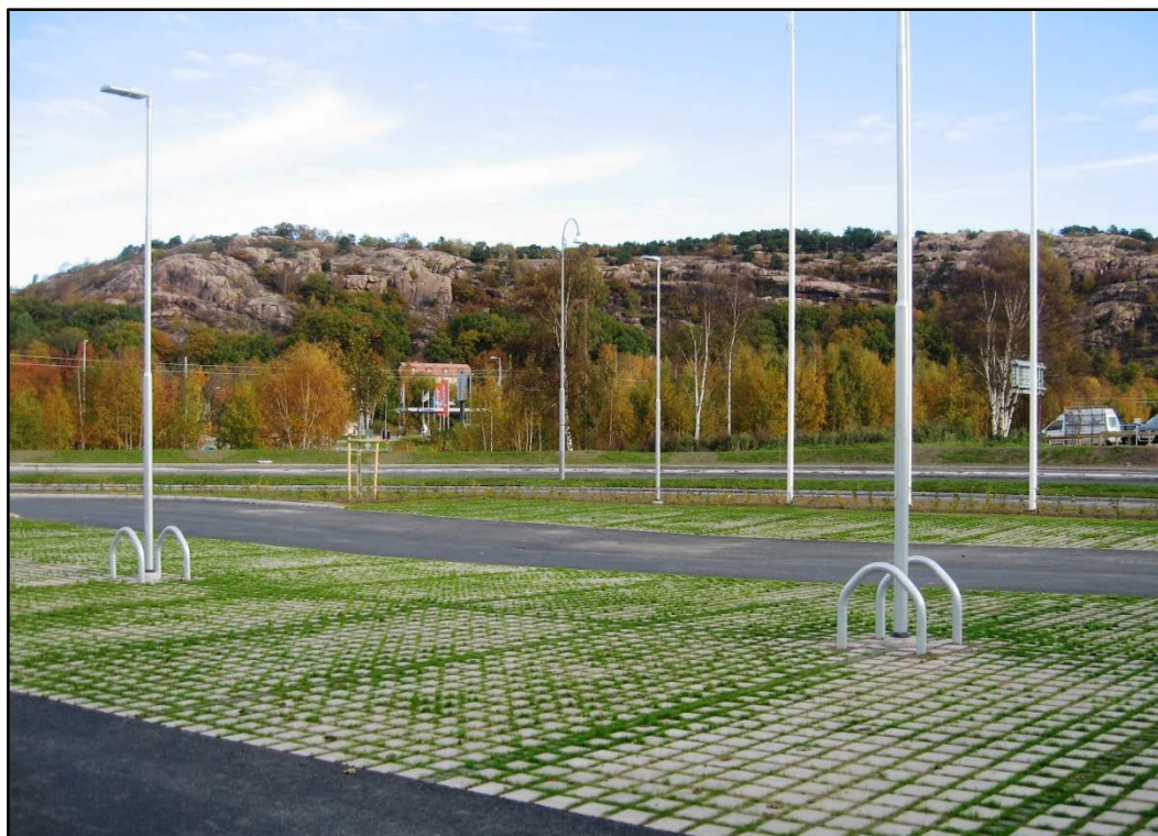
Figur 8. Större parkeringsyta med genomsläpplig beläggning. Någon form av genomsläpplig beläggning föreslås på ett ställe i planområdet. Se bilaga 2 för placering. bild: Norconsult
